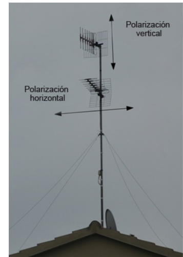
Figura 13. Antenas con polarización horizontal y vertical; ejemplo PDMA lineal
